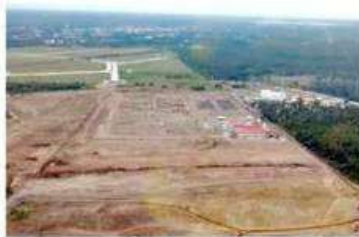
Las obras de la refinera de Dos Bocas apenas están en la etapa de relleno y apianado del terreno.
