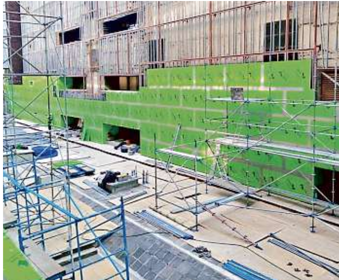
■ Paneles que se instalan en las fachadas de cinco edificios de San Lázaro, donde se ubican comisiones y oficinas.
