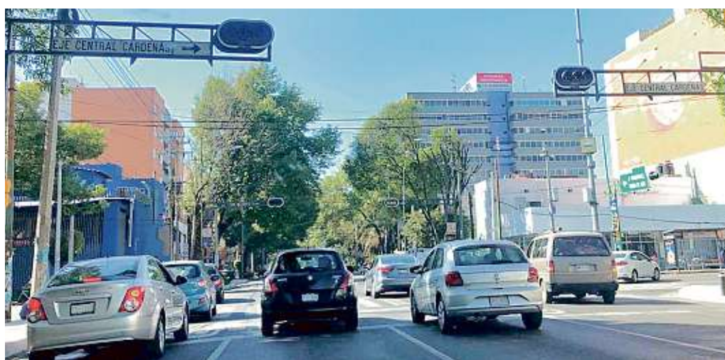
Cientos de semáforos en la CDMX, como en el Eje 5 Sur, quedaron fuera de servicio.
