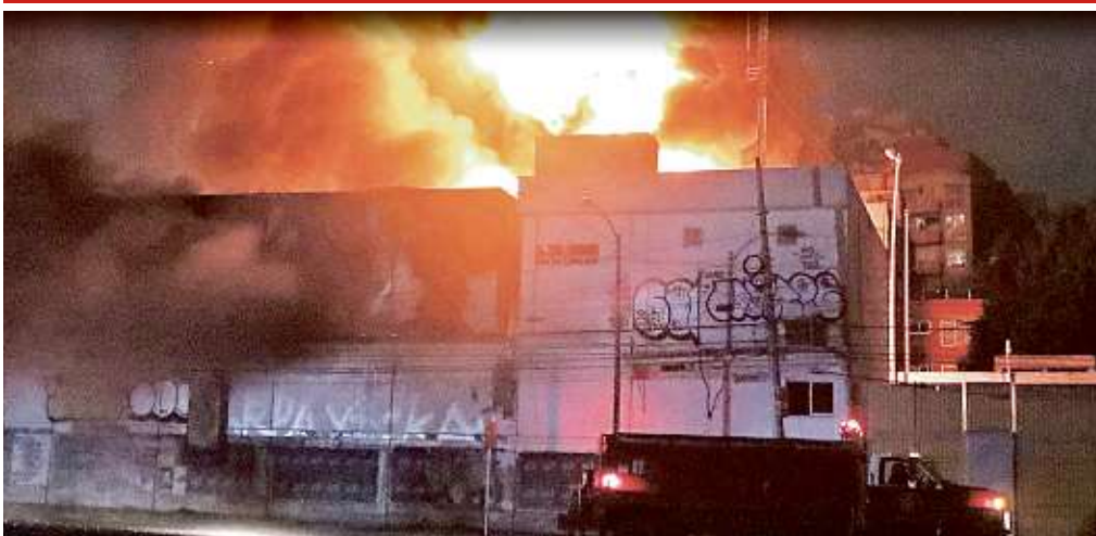
La subestación que se incendió ayer tiene cerca edificios habitacionales y una gasolinera.
