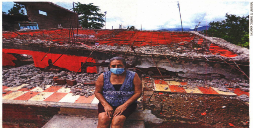
Guerrero. — Los habitantes de Xaltianguís fueron de los más afectados por el sismo del 7 de septiembre; entre ellos está Elena Moreno, cuya casa se desplomó. Los damnificados se quejan de que no todos fueron censados y dicen que se minimiza el impacto del terremoto. | A14 |
