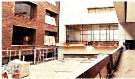
Los trabajos en la fachada del edificio H están en curso.
