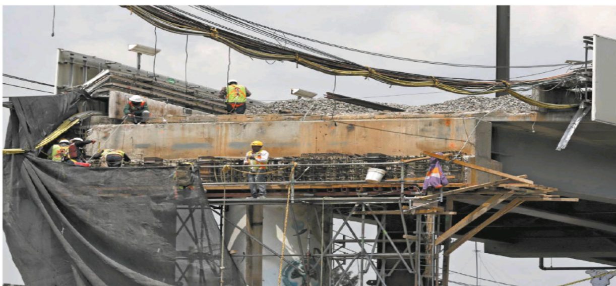
Entre los trabajos se encuentra la reconstrucción de dos traveses del tramo elevado entre las estaciones San Lorenzo Tezonco y Olivos de la Línea 12.
