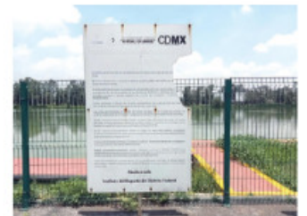
NI LOS LETREROS de las instalaciones de Cuernavaca están en buenas condiciones.
