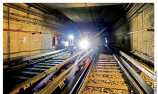
Los rieles viejos y los cables desgastados de la Línea 1 del Metro pronto quedarán en el recuerdo, porque será modernizada CDMX P. 7
