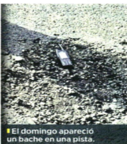
En 2020, las pistas del aeropuerto tuvieron obras y mantenimiento mayor. Ahora, la rehabilitación regresa al AICM.
