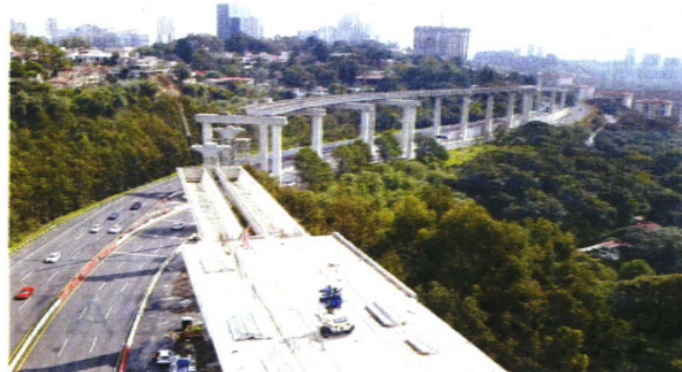
La construcción de este tren comenzó en julio de 2014 y ahora lleva 77.5% de avance.
