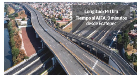
EL CAMINO de Tonanitla se podrá transitar a 90 km por hora.
