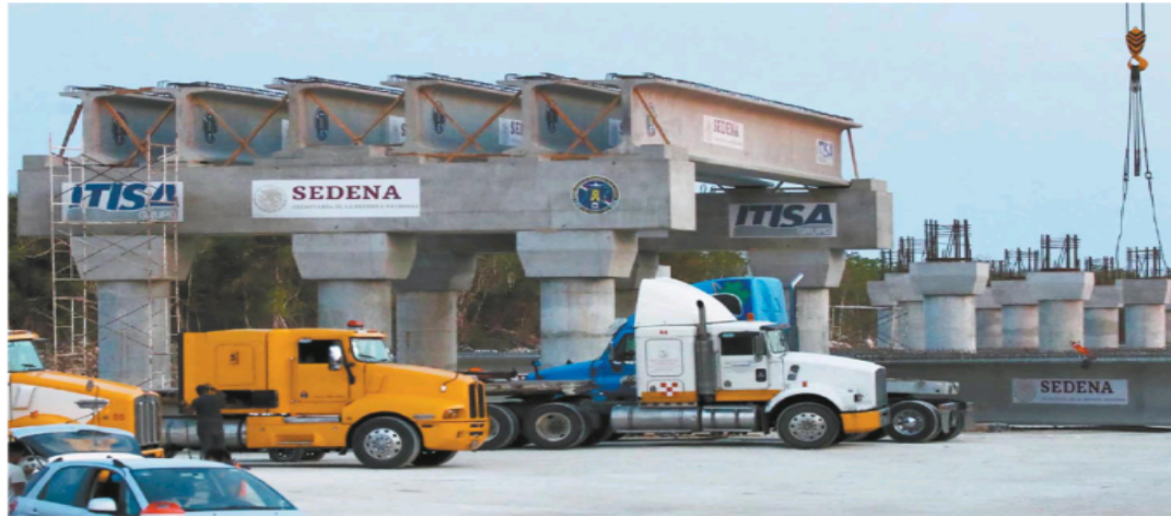
En diversas partes de las estructuras de concreto es visible el logotipo de la Secretaría de la Defensa Nacional.
