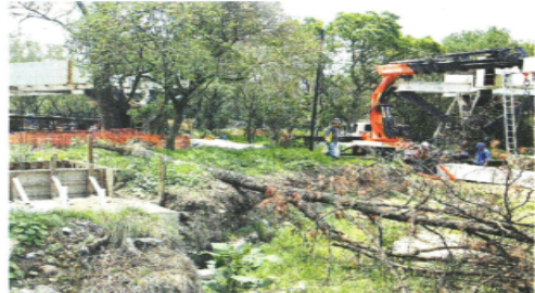
Los trabajos para construir la Calzada Chivatito ya iniciaron.
