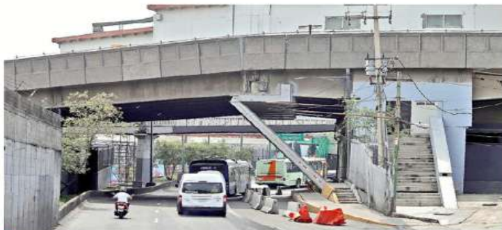
El Gobierno capitalino realiza obras de mitigación para contrarrestar el hundimiento
