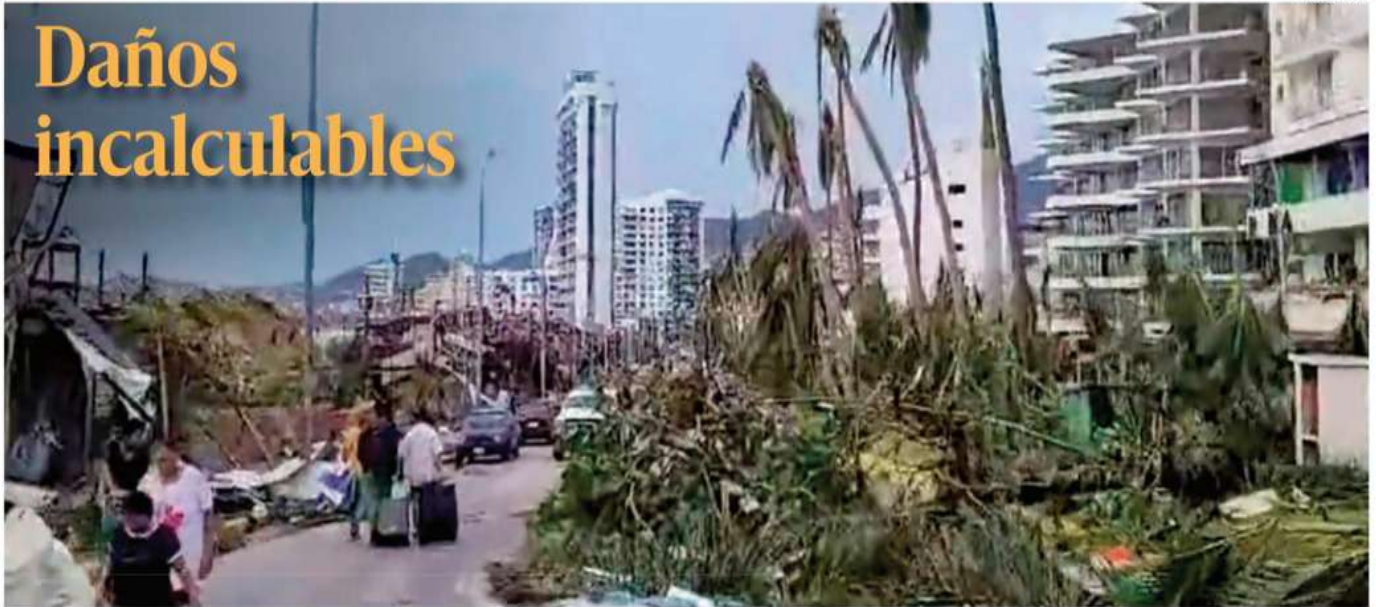
Palmeras, autos, ventanales, anuncios espectaculares, techos y palapas de la costera Miguel Alemán no soportaron los vientos y ráfagas con las que impactó el huracán Otis los primeros minutos de ayer miércoles.
