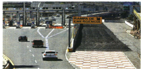
Una de las rampas de emergencia en la México-Toluca.
