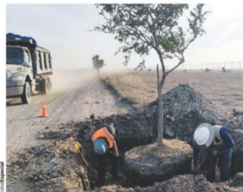
AVANCES de la construcción del tren México-Pachuca.
