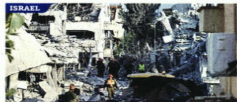
Un misil disparado desde Irán impactó al sur de Tel Aviv, provocando graves daños en inmuebles.
