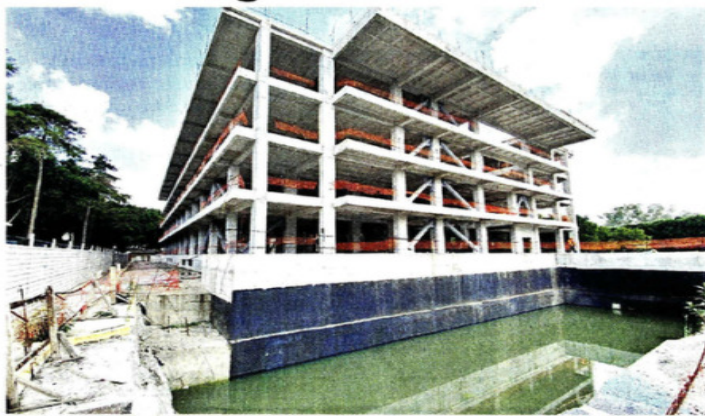
Desde finales de 2024, la construcción del Edificio "J" de San Lázaro fue suspendida, debido a la falta de presupuesto.
