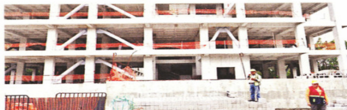
■ La Administración de la Cámara de Diputados informó sobre la reactivación de la obra.
