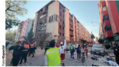
ASPECTO de los inmuebles afectados, ayer.
