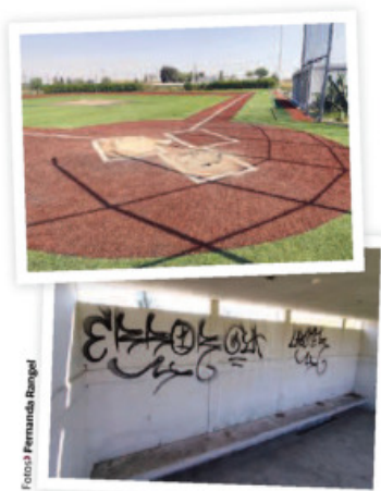
ARRIBA, suelo sin arcilla en la zona de la caja de bateo; abajo, un dugout vandalizado.
