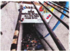
UNO de los sitios que se planeaba rehabilitar.
