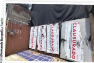
AVISO de suspensión en la obra, ayer.
