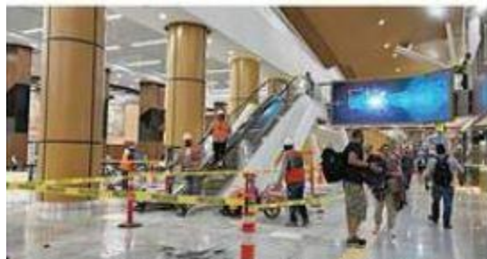
Trabajadores ultimán los detalles de la remodelación en el aeropuerto capitalino.
