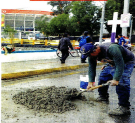
A marchas forzadas y entre la lluvia, continúan las obras afuera del Estadio mundialista en la CDMX.
