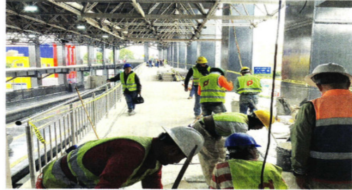
A MEDIAS. Oficialmente ayer inició operaciones la estación del Metro Chabacano de la L2, pero las obras continúan.
