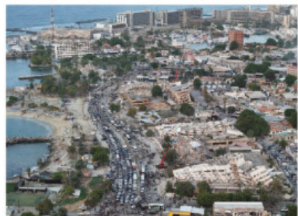
VISTA aérea de los escombros de La Guaira, ayer. Foto: Reuters
